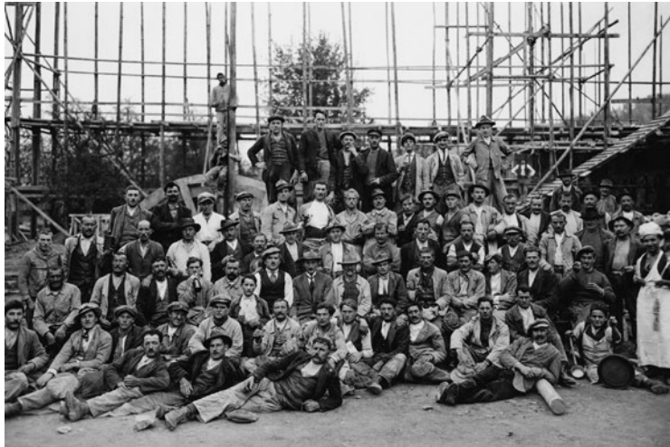
Am Bau beteiligte Mitarbeiter auf der Baustelle
