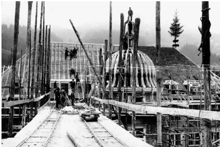
Das Bau-Zimmereigeschäft Peter Müller Root errichtete die Kuppel
